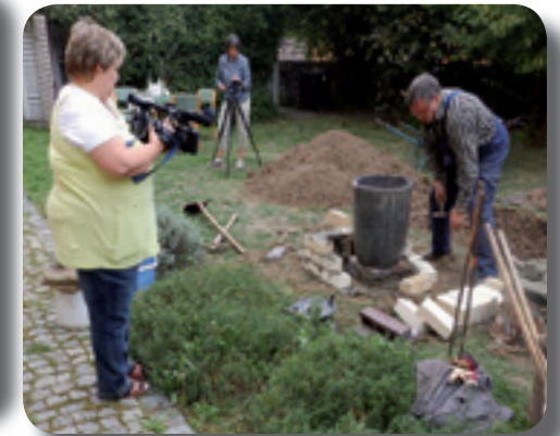
Rund um den Graphit-Tiegel wird aufgemauert..
