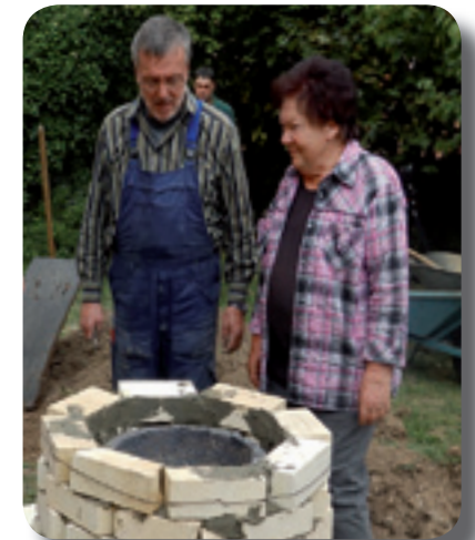
Rund um den Graphit-Tiegel wird aufgemauert..
